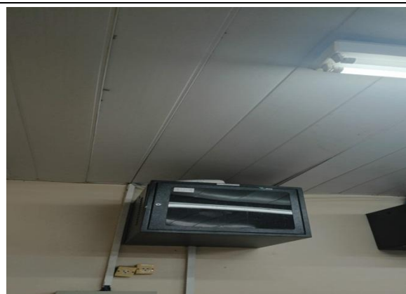
TROCA DE FORRO
