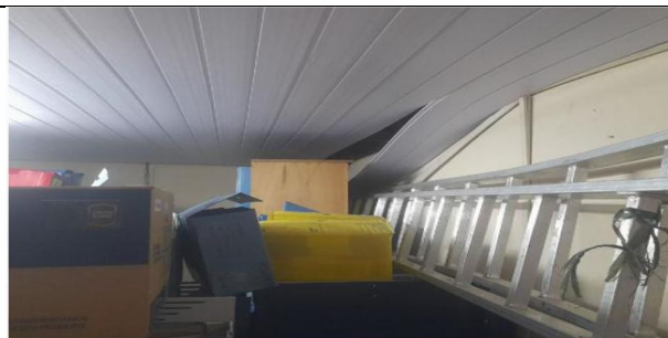
REPARO NO FORRO DO DEPÓSITO
