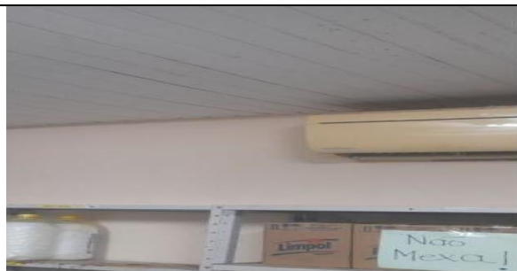
REPARO NO FORRO DO DEPÓSITO
