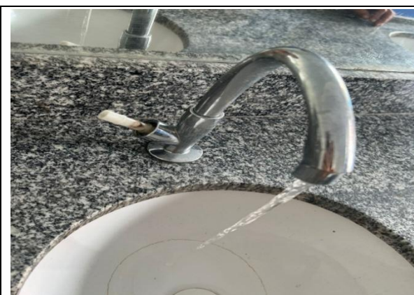
TROCA DE TORNEIRAS
