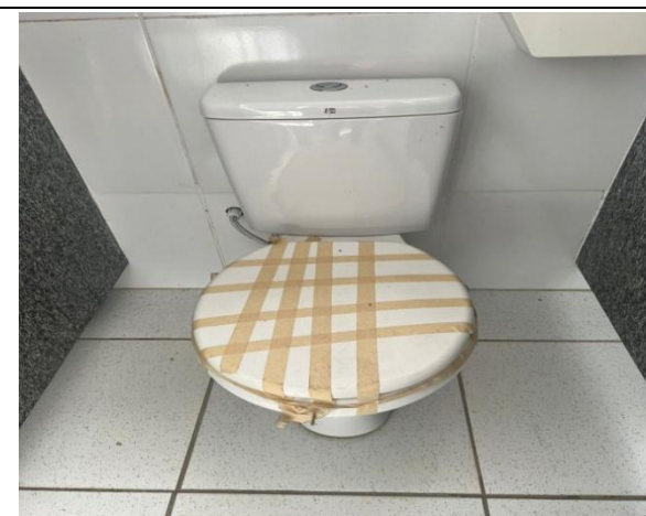
REPARO NO VASO SANITÁRIO
