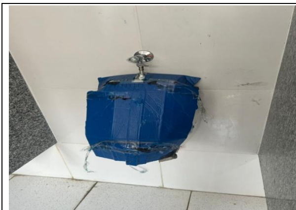
REPARO NO MICTÓRIO
