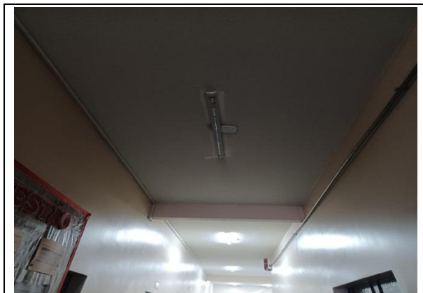
Reparo no telhado
