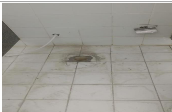
COLOCAÇÃO DE VASO SANITÁRIO
