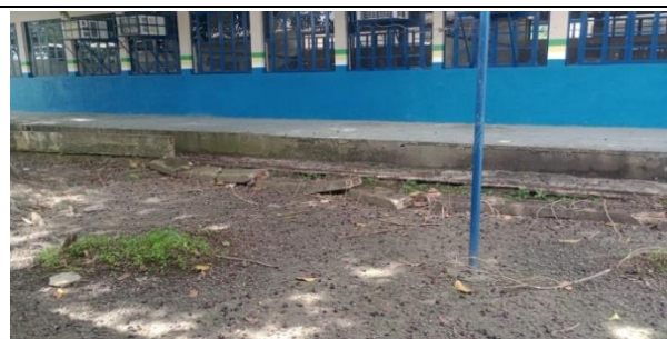
REPARO DE CANALETAS
