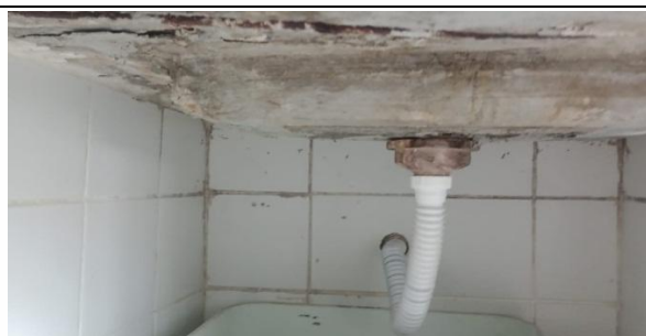
REPARO NA PIA
