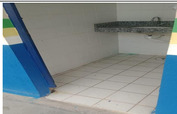
COLOCAÇÃO DE PORTAS
